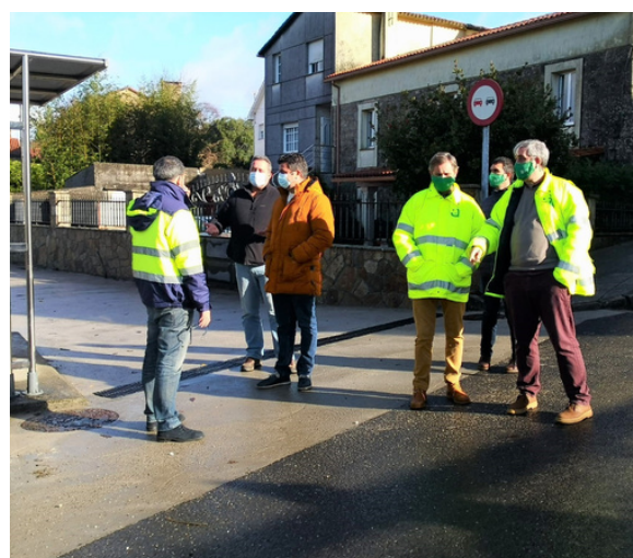
Recollida de pluviais en Biduído de Abaixo
